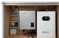
太陽光発電と連携した大容量蓄電池 オフグリッド電源システム
